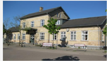
Lunderskov Stations hovedbygning og pakhus 1866, tinglyst fredet i 1992.
