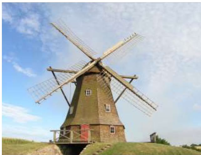
Blåbæks Mølle er jordstående med underliggende gennemkørsel
